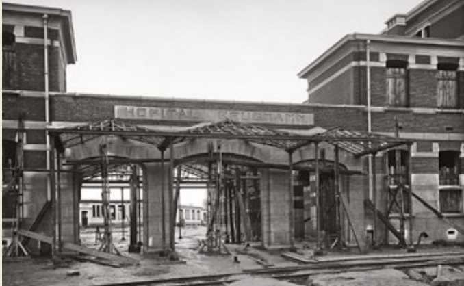
Het ingangsportaal in aanbouw in 1912. (foto R.V. Duquenne, AOCMWB)
