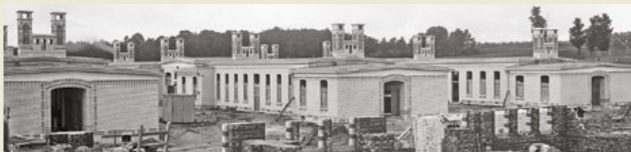
De paviljoenen in aanbouw met hun 'woud' van ventilatieschoorstenen op het dak.
