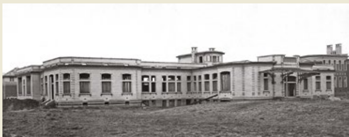
Het paviljoen kinderheelkunde (B) in het stadium van de voltooide ruwbouw. (foto R.V. Duquenne, AOCMWB)
