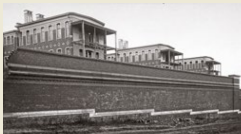
De panoramische terrassen van de heelkundezalen met zicht naar het westen. (foto R.V. Duquenne, AOCMWB)
